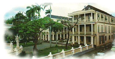
Regierungsgebäude und Parlament von Mauritius in der Hauptstadt Port-Louis
